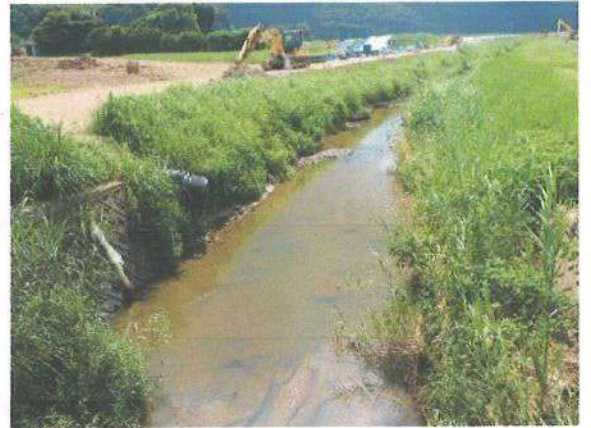
幡鉾川河川工事
